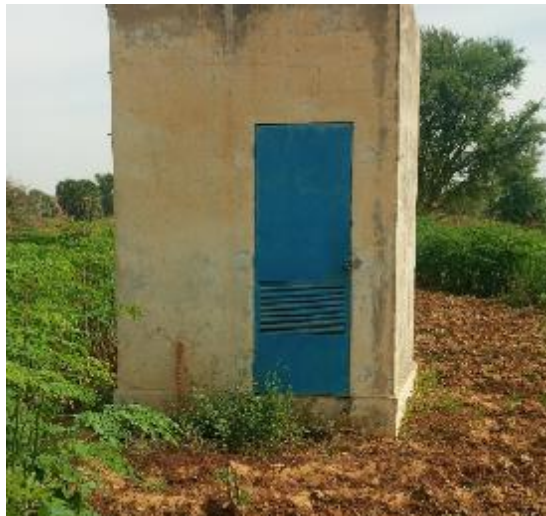
Abri technique de station de pompage d'eau d'irrigation (Niger)
