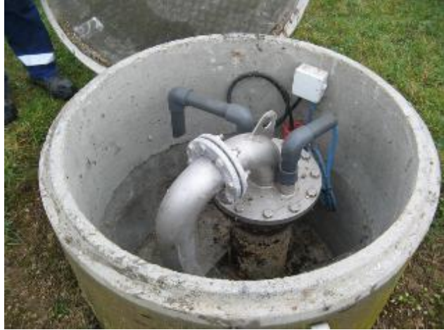
Tête de forage protégé par buse
